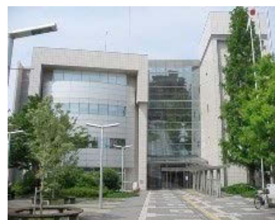
横浜市泉区総合庁舎は地中熱を利用しています
