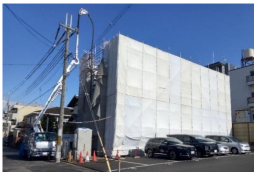
建設中の新農会館（12月13日撮影）
